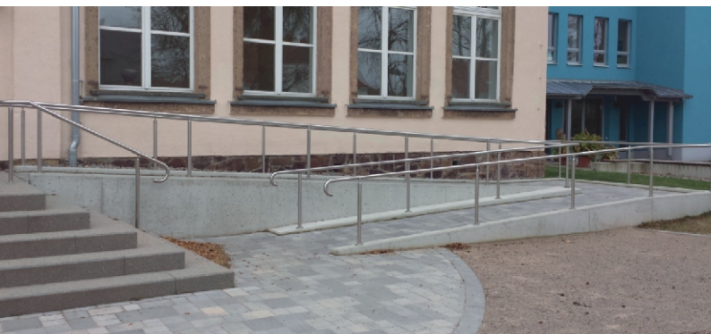
Beispiel Eingangsbereich mit Rampe Waldorfschule Chemnitz
